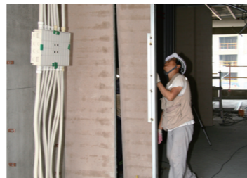
1차 패널 설치 단열 및 전기 공사 전 1차 패널 설치 및 고정
