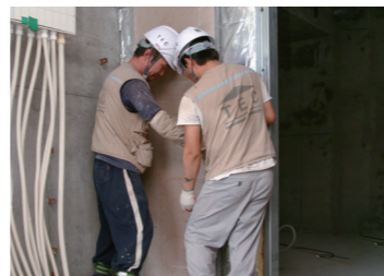
2차 패널 설치 및 완료 단열 작업 후 2차 패널 작업 시행 및 작업 완료
