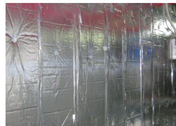
단열재 취부 패널 단열·차음 성능 보강을 위한 단열재 취부 작업 시행
