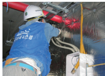
전기 배관 공사 1차 패널 설치 완료 후 전기·배관 연결 및 배선 작업 시행
